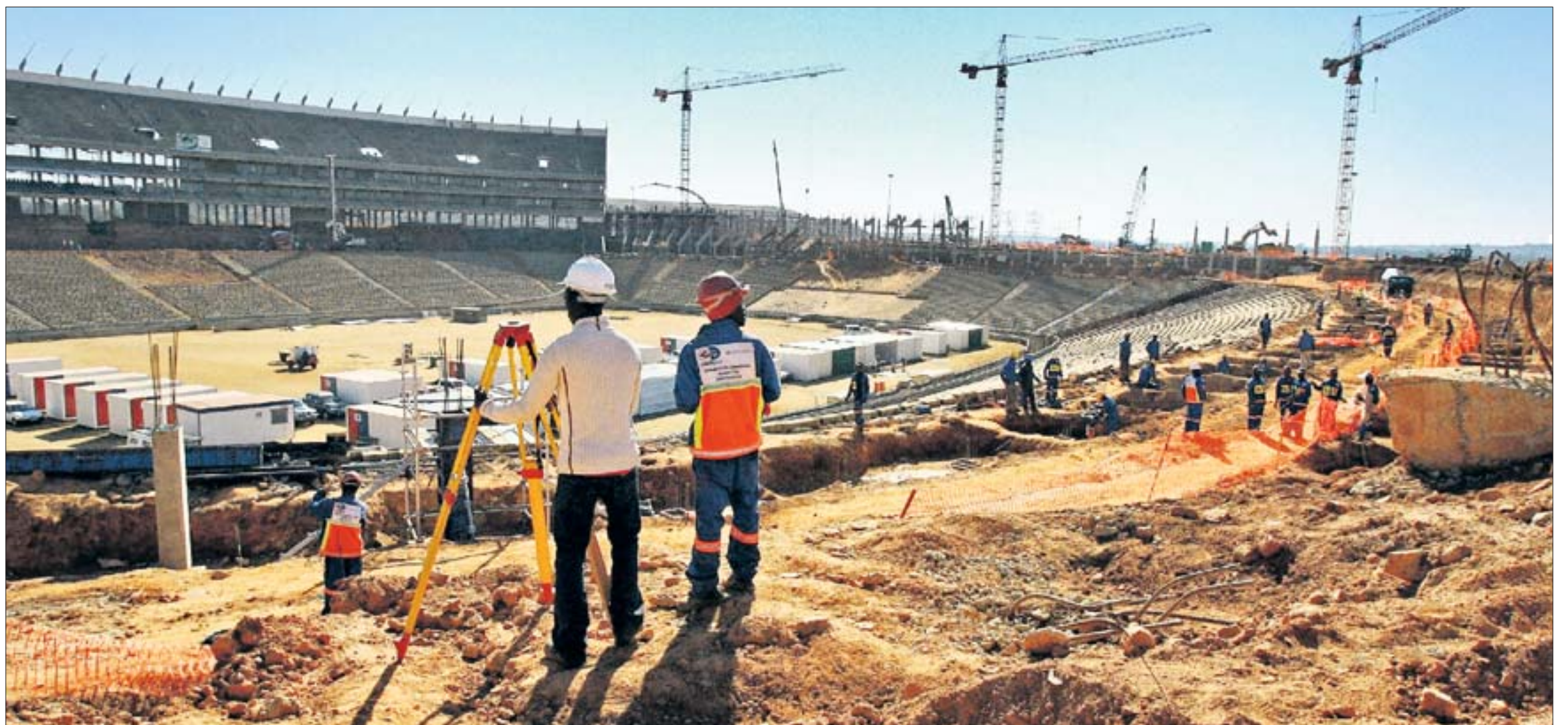
Große Pläne, große Mühe: Aus dieser Baustelle soll einmal das neue Stadion „Soccer City“ in Johannesburg werden, die größte Arena der WM 2010. Es bleibt viel zu tun bis zum Eröffnungsspiel, und längst läuft nicht alles reibungslos. afp
